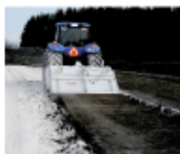
Stabilisation à la chaux
